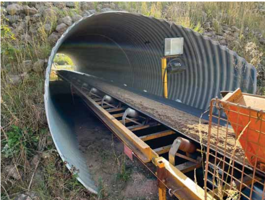
Foto af eksisterende underføring
