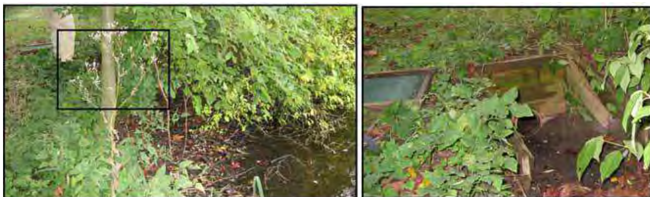
Figur 13b: Overløb ved Rajgrav Mose. På fotoet til venstre er overløbets placering angivet ved en sort ramme. Bemærk vandspejlets niveau (9. oktober 2003). Fotoet til højre viser et nærbillede af overløbet.
