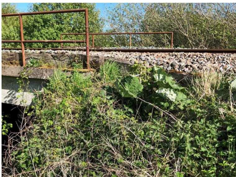
Figur 3 Ballastskot over Vivede Mølleå med udkraget svelle, der holder skærver ved overgang mellem bro og bandedæmning
