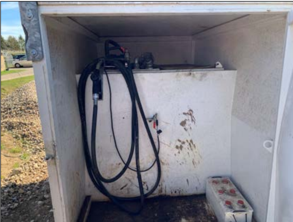
Foto 4: Brændstoftank med dobbeltbund (Lokation B)
