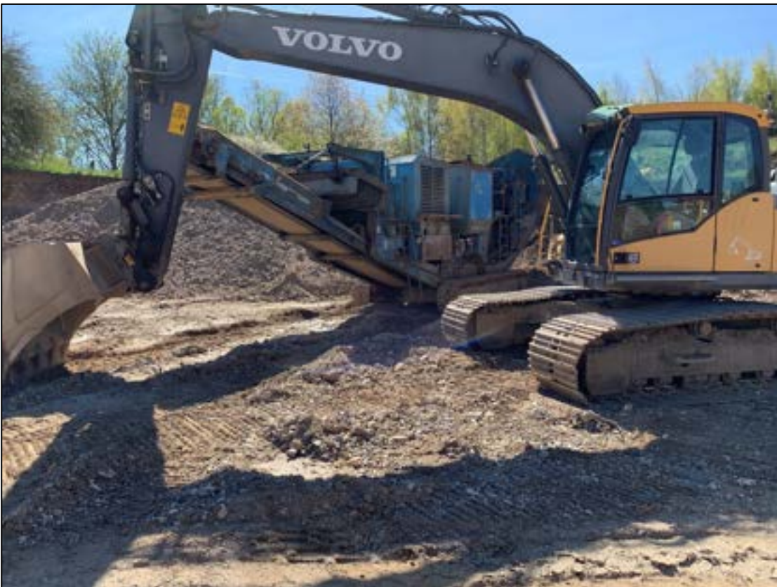
Foto 6: Gravemaskine og knuseranlæg (Lokation C)
