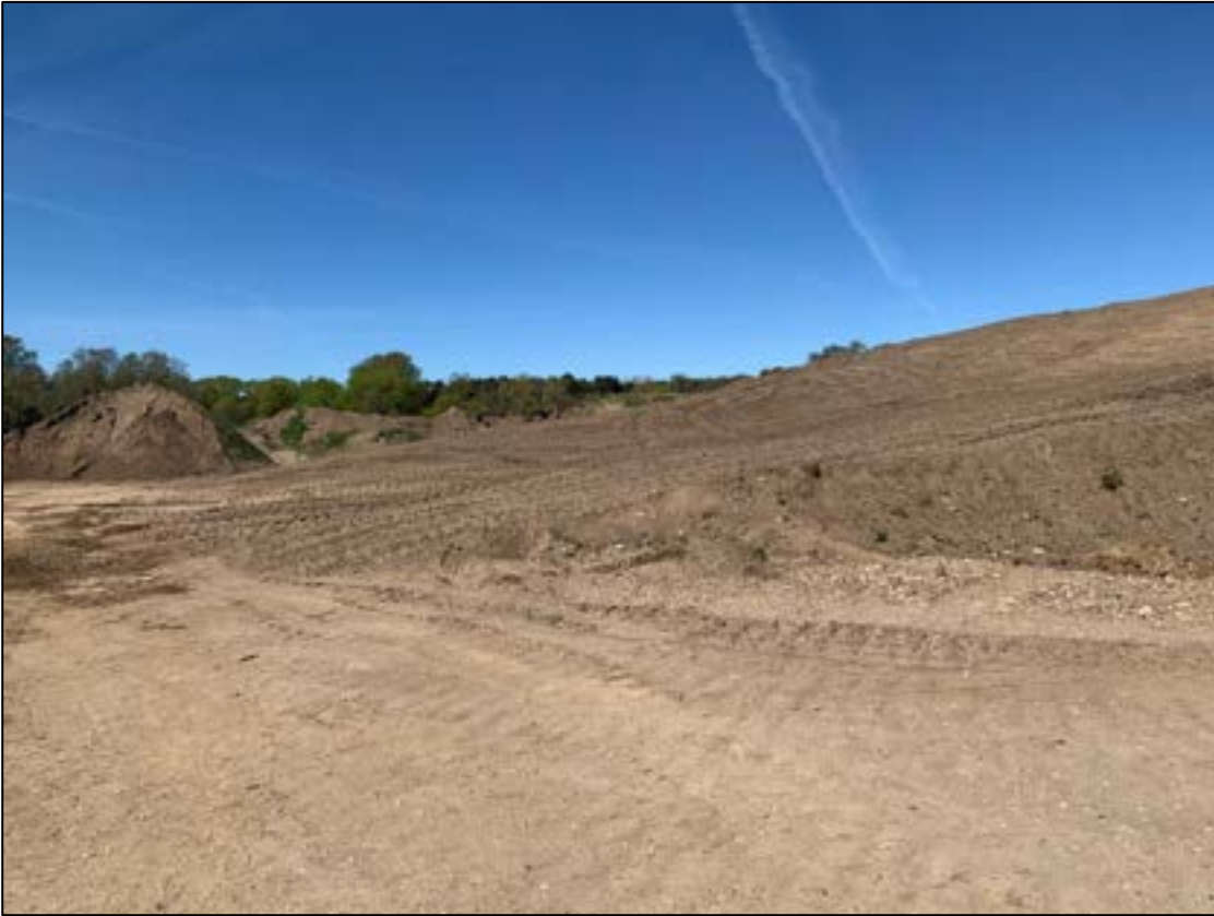
Foto 13: Oplag af overjord fra graven (Lokation F)
