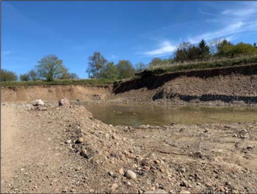
Foto 9: Indvinding ned til 0,5 meter over grundvandsspejl og det nordøstlige hjørne i graven (Lokation E)
