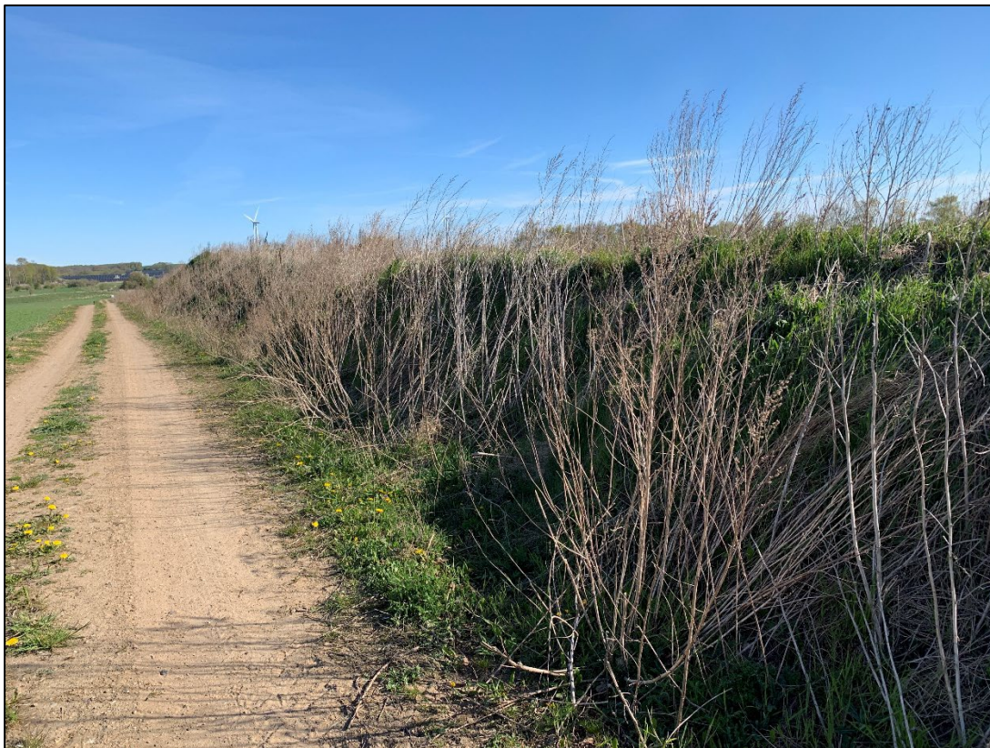
Foto 7: Støjvold etableret i muldjord (Lokation C)
