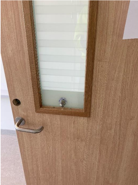
Billede af dør til patientstuen. Blinddæksel er endnu ikke monteret.
