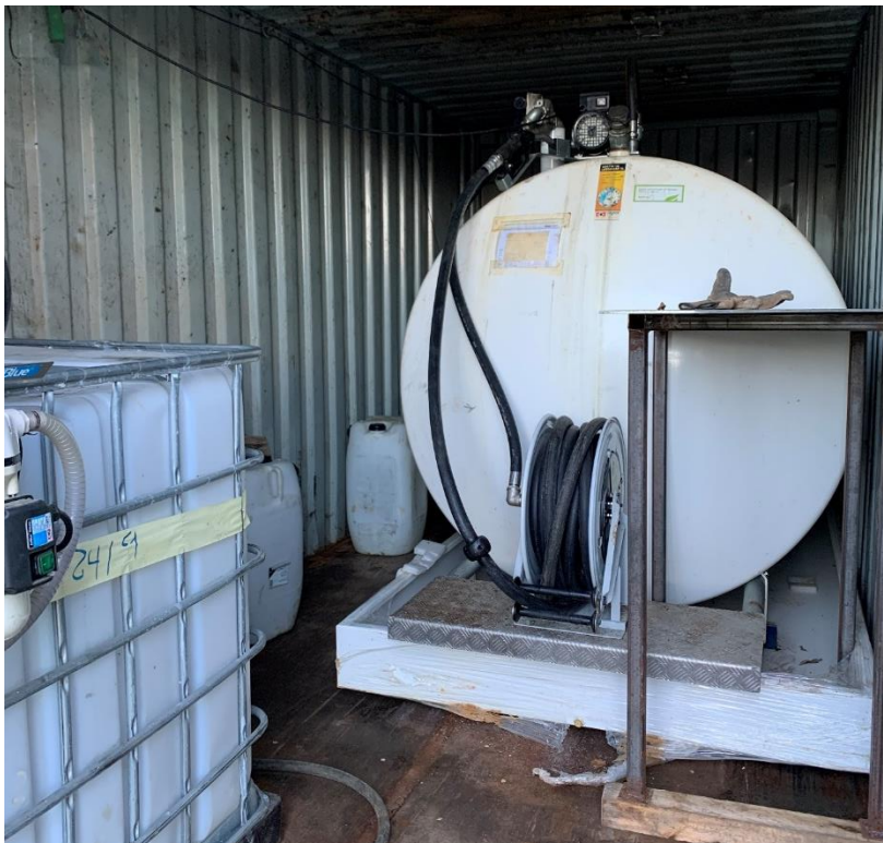
Foto 4: Tank i container med sump.
