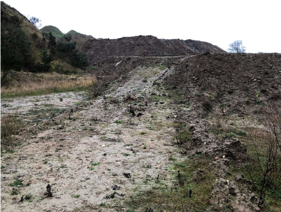
Figur 6: Foto taget mod vest fra position 4 og ind mod område, hvor der pt. sker opfyldning med jord.
