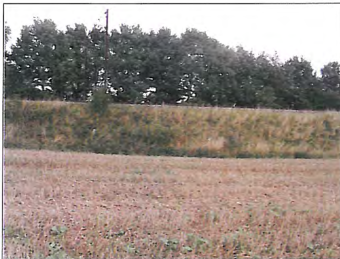
Foto 1: Banedæmningen set fra det undersøgte areal.
