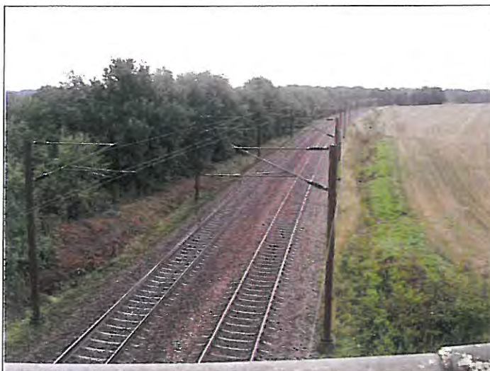
Foto 2: Banedæmningen set fra nærliggende vejbro.
