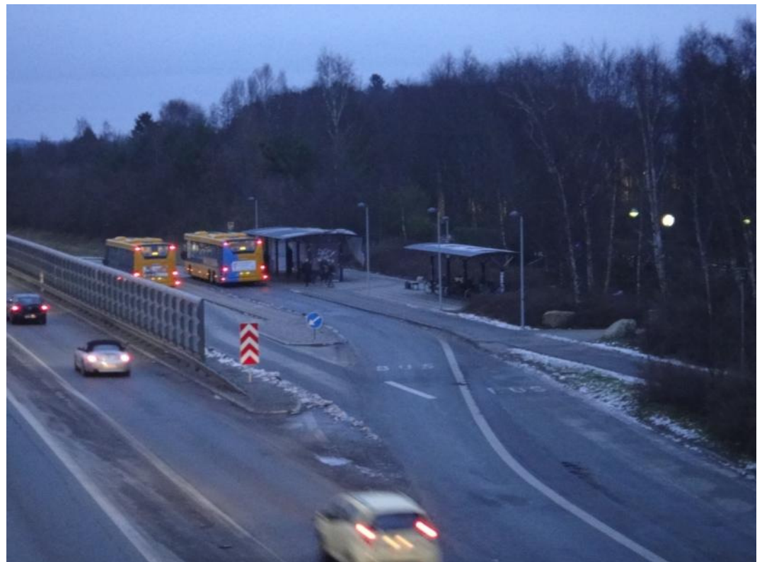
Busstoppestedet ved Helsingørmotorvejen ved Nærum Station.
