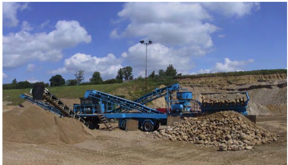
Figur 4.6: Mobilt stabilgrusanlæg, hvor tørsortering og knuser er bygget sammen.
