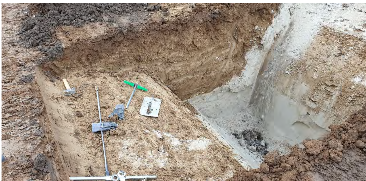
Foto 4: Prøvegravning PG4, Hvidt Smeltevandssand under moræneler.
