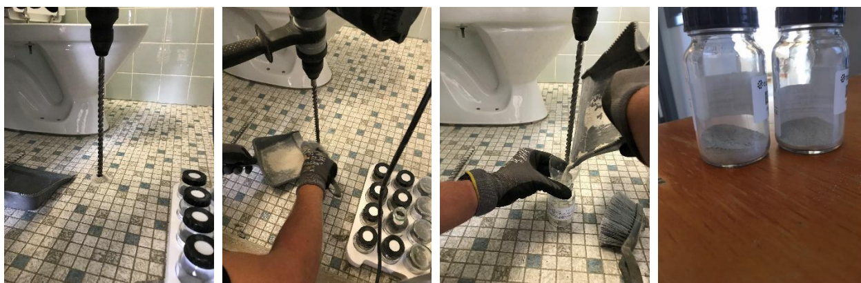
Figur 3.13 Udtagning af borestøvsprøver til kemisk analyse for indhold af forureningskomponenter ifm. gennemboring af betongulv før poreluftprøvetagning. Frit efter /49/.
