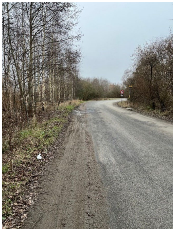
Figur 10a Tilstand af vejen den 16. januar 2025: bløde kanter på begge sider, bemærk busstoppestedet i svinget
