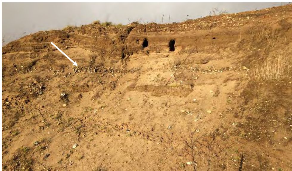
Figur 8: Profil i den nordlige del af NCC grusgrav. Der ses mellem-grovkornet smeltevandssand med tynde lag af grus og sten. Et sådant lag er markeret på figuren.
