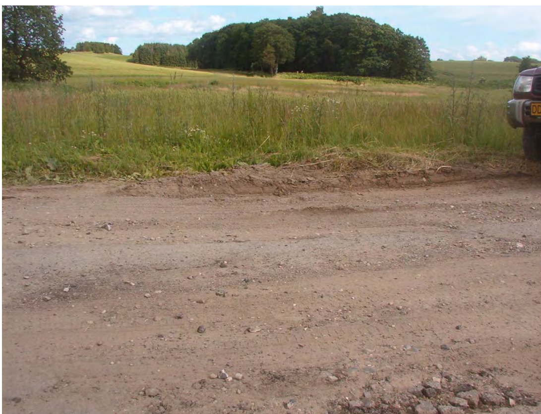
Foto 4: Typisk sætning på Egemosevej efter få dages kørsel i uge 30 2011.
