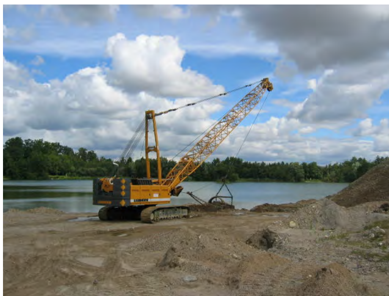
Figur 3.3.18: Indvinding under vand foregår med en wiremaskine.
