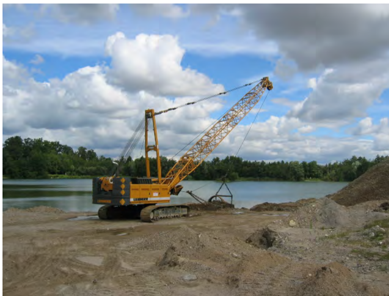
Figur 3.3.18: Indvinding under vand foregår med en wiremaskine.
