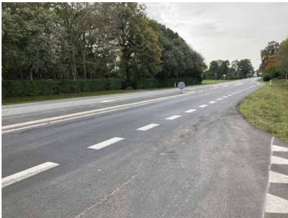
Foto 2: Hældeanlæg og svingbane ind på det ansøgte areal fra Kalundborgvej.
