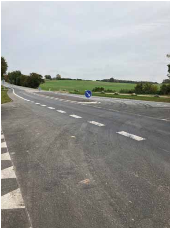
Foto 3: Hældeanlæg og svingbane ind på det ansøgte areal fra Kalundborgvej.
