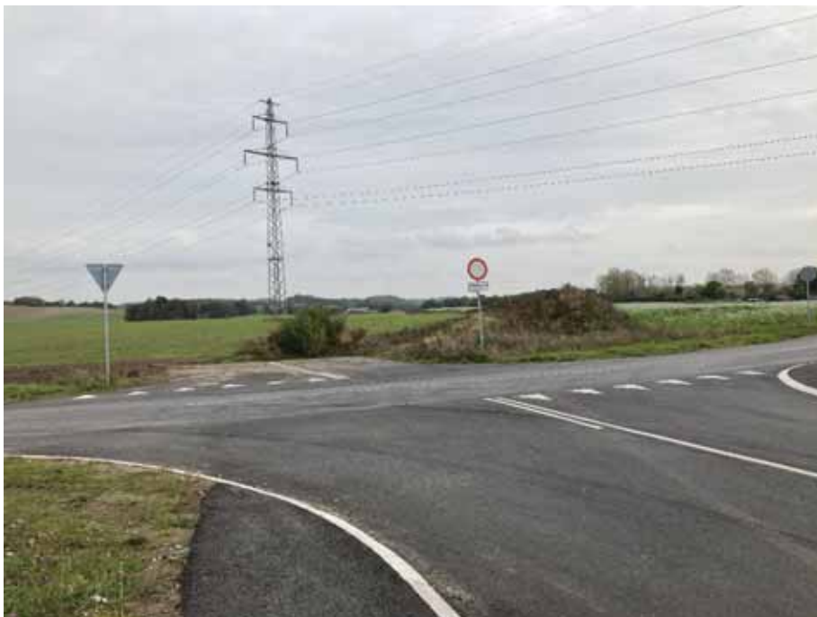
Foto 4: Overkørsel lavet af Kalundborg kommune til matr.nr. 5g Bregninge By, Bregninge set fra krydset imellem Vilhelmshøjvej og Torpevej.
