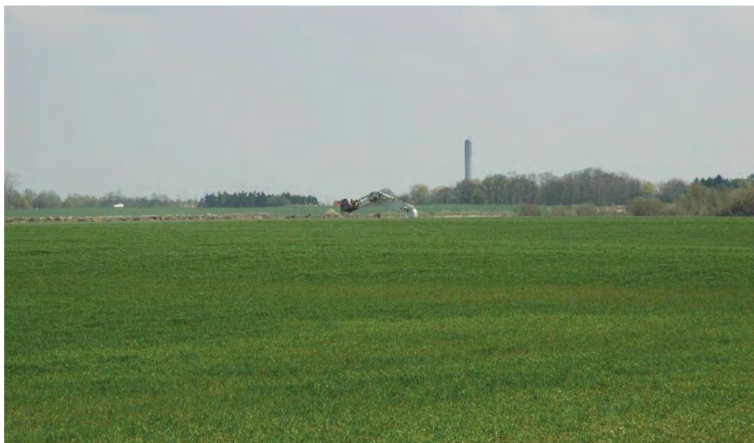
Figur 5.9 Rømning af overjord med gravemaskine. Kun armen på gravemaskinen er synlig.
