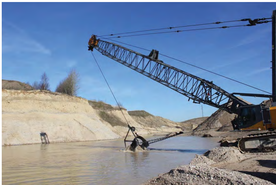
Figur 3.8: Indvinding under grundvandsspejlet foregår her med en wiregravemaskine.
