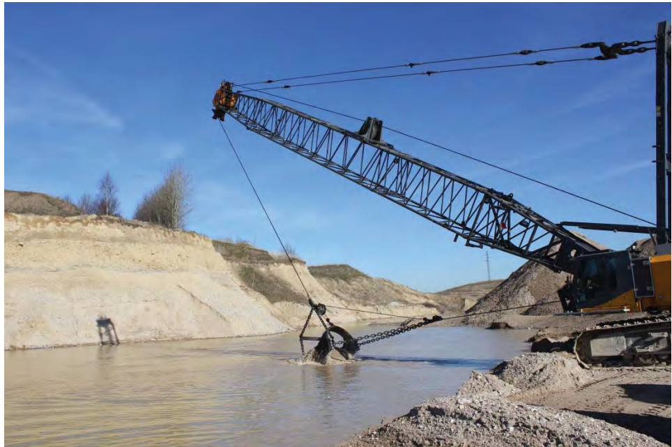
Figur 4.11: Indvinding under grundvandsspejlet med en wiregravemaskine.
