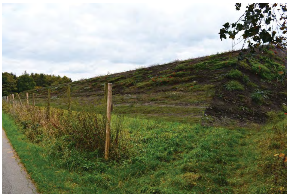
Figur 7.5: Fotostandpunkt 2. Fremtidig udsigt fra Elmelygårdsvej nord for det vestlige ansøgte areal under råstofindvindingen, hvor overjord er oplagt i en jordvold på 2-4 m's højde.
