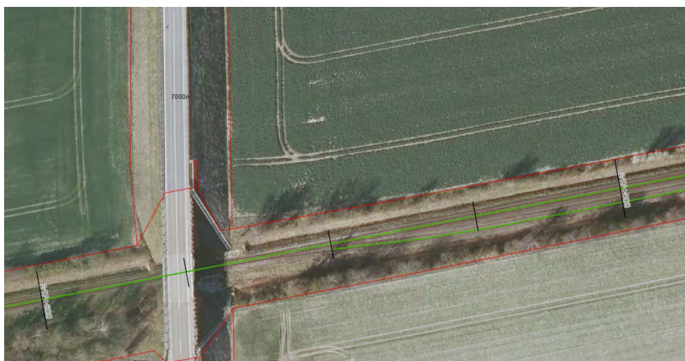
Figur 9: Sporskifte St. 247.480 - St. 247.530, (km 173.45)
