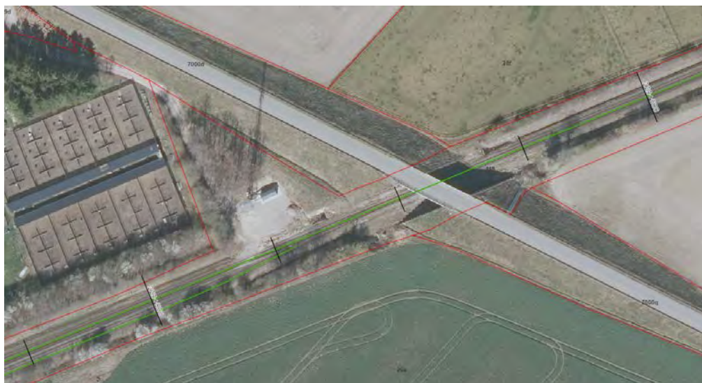
Figur 4: Sporskifte St. 229.700 - St. 229.750, (km155.700)
